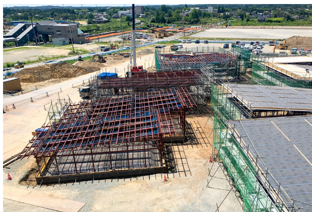
建設が進むクマSUNテラス。左奥は JR 大野駅
