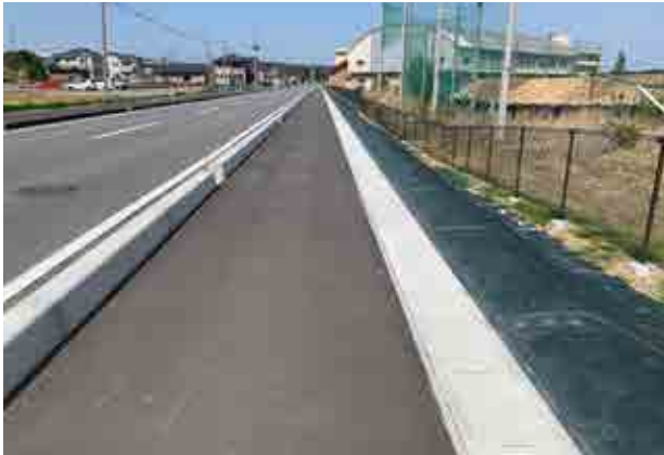
新たに歩道が整備された町道西 49 号線
