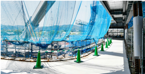
2階部分のぐるぐるバルコニー
