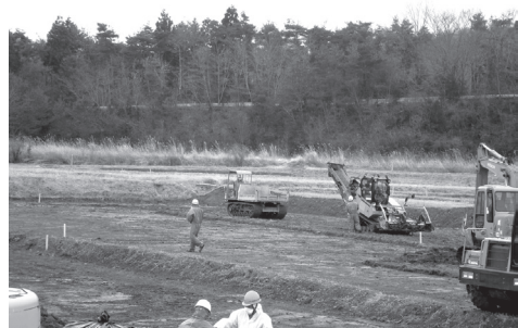
除染作業が進む南平地区
