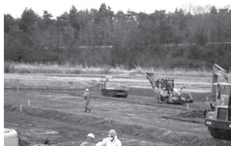
除染作業が進む南平地区
