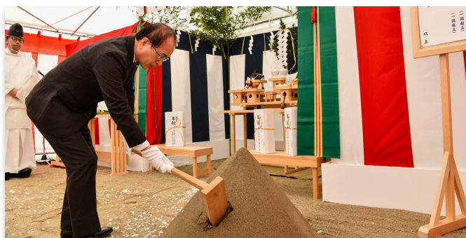
工事の安全を祈願し鍬入れする吉田町長
