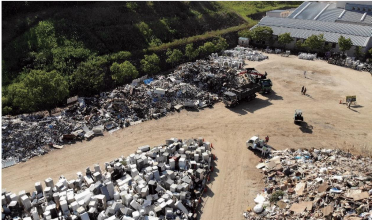
図 3-10-3 吉備路クリーンセンター隣接の多目的広場（被災地一次仮置場）
