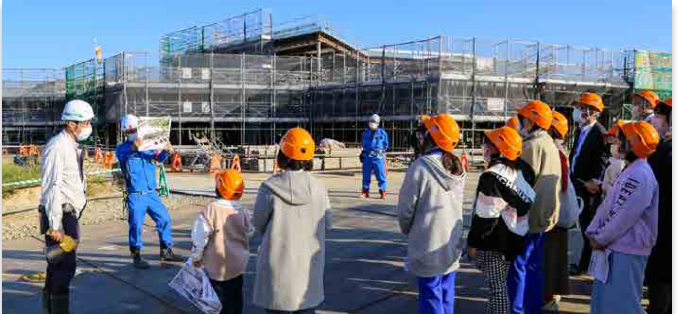
建設中の教育施設を見学する児童生徒
