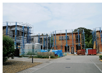
建設中の子育て住宅
