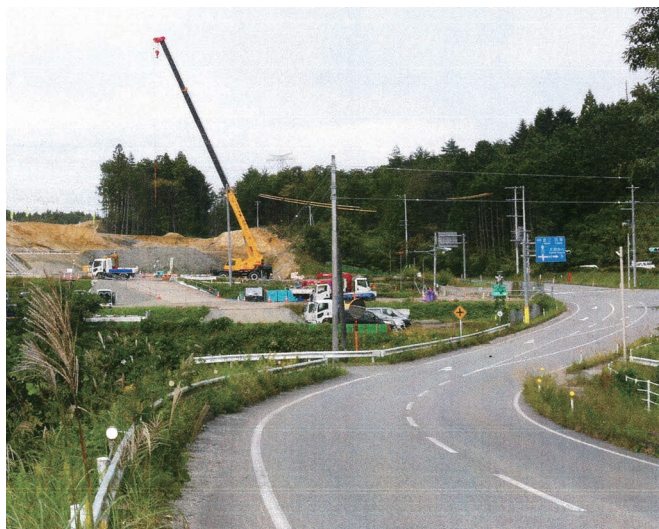
企業立地に向け造成が進む西工業団地
