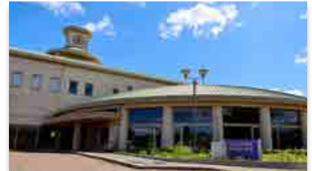
解体予定の町図書館・民俗伝承館
