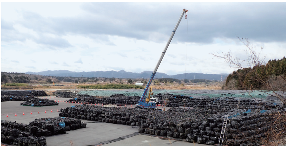
フレコンバッグの下は素敵な田んぼでした(熊川地区)
