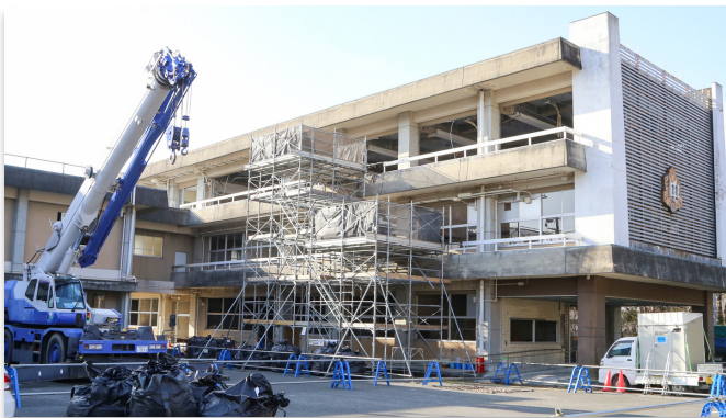
解体が始まった大熊中の校舎
