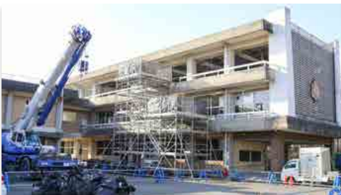
解体が始まった大熊中の校舎
