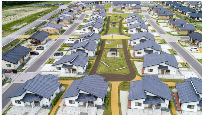
全建賞を受賞した第2期災害公営住宅
