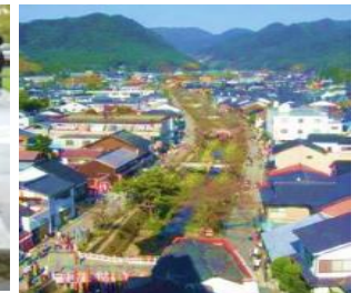
河川整備事業 (山口県 一の坂川)
