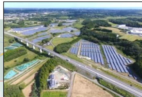
大熊エネルギー・メガソーラー発電所 (約8.6MW※)
