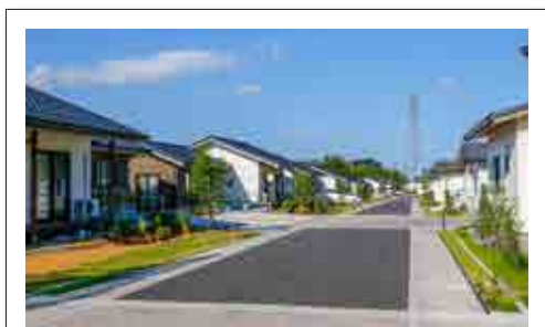
②入居が進む災害公営住宅
