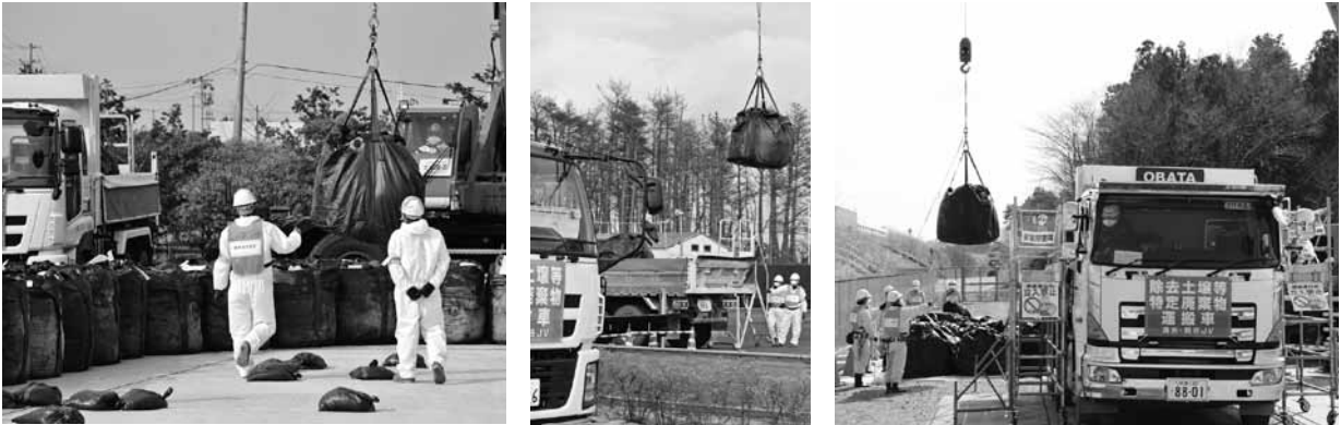
(右から) 仮置き場から運び出され、積み替えを経て保管場に移される除染袋
