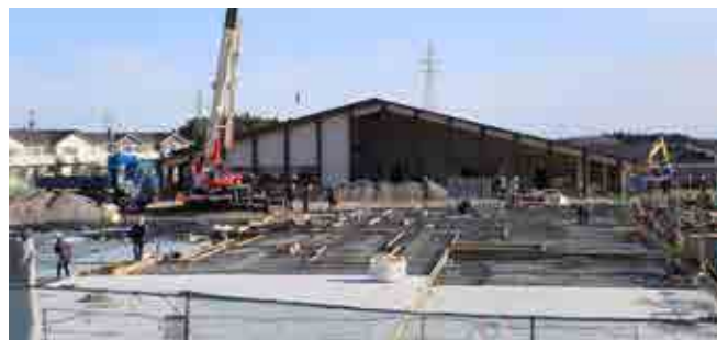
建設中の商業施設。手前は交流施設の用地
