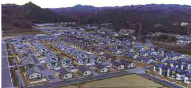
大川原に建ち並ぶ災害公営住宅と再生賃貸住宅
