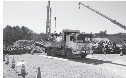
仮置場からの搬出作業状況
