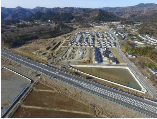
①北東側からの上空写真
