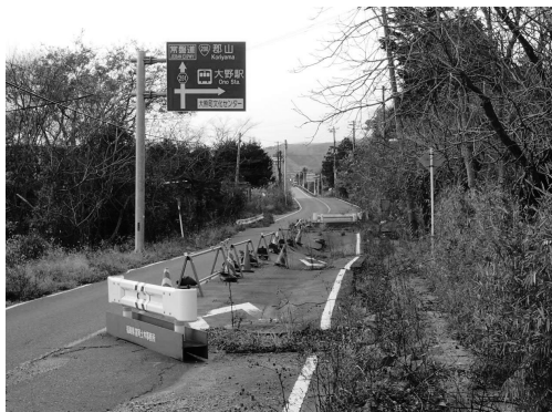
②鮎沢第二ため池脇の道路崩落の様子
