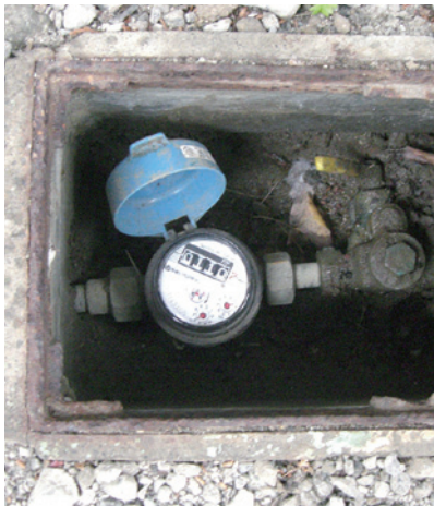
漏水をチェック
