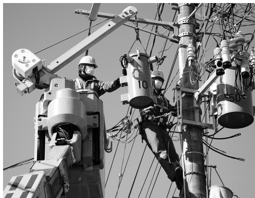
改修工事をする社員
