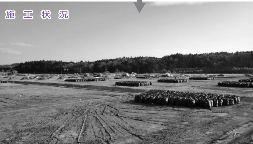
仮置場造成工事で出た表土等をつめた大型土のうが整然と並んでいます。
