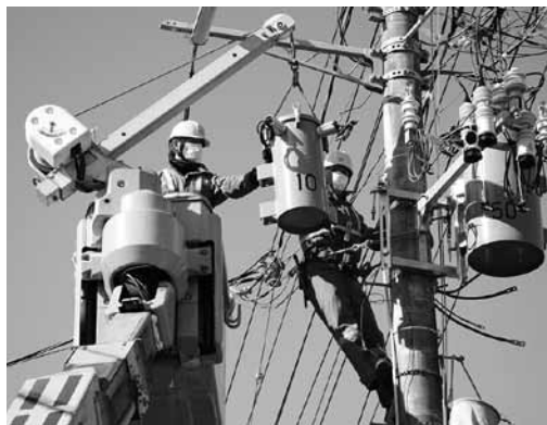
改修工事をする社員
