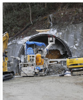
工事が始まったトンネル
