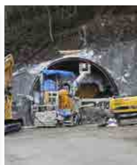
工事が始まったトンネル
