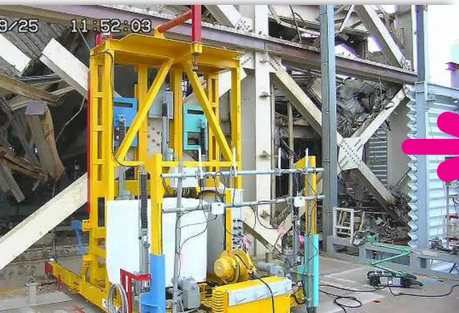
切断した筋交いを引き出す作業
