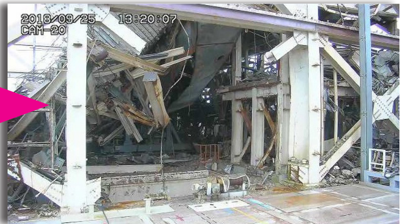
筋交いの引き出し後
