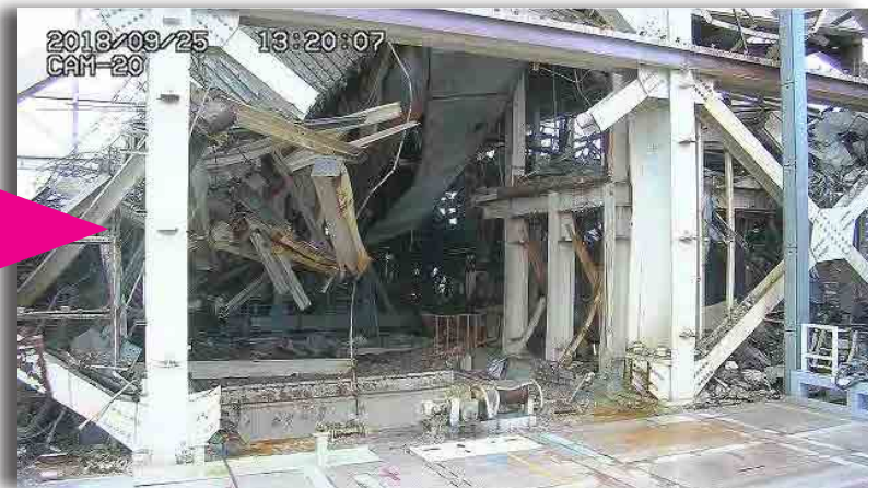
筋交いの引き出し後
