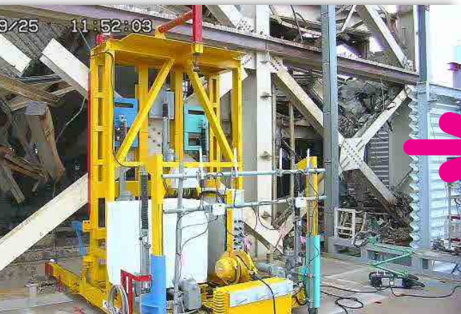
切断した筋交いを引き出す作業
