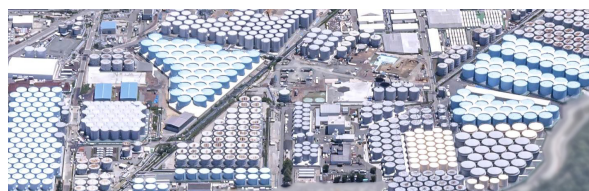
原子力発電所構内に設置された保管タンク群
