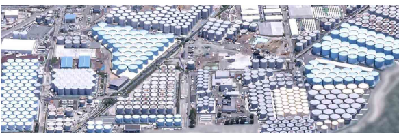
原子力発電所構内に設置された保管タンク群
