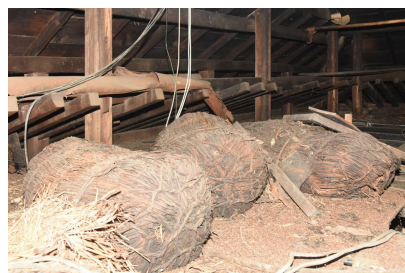
民家の屋根裏で見つかった俵
