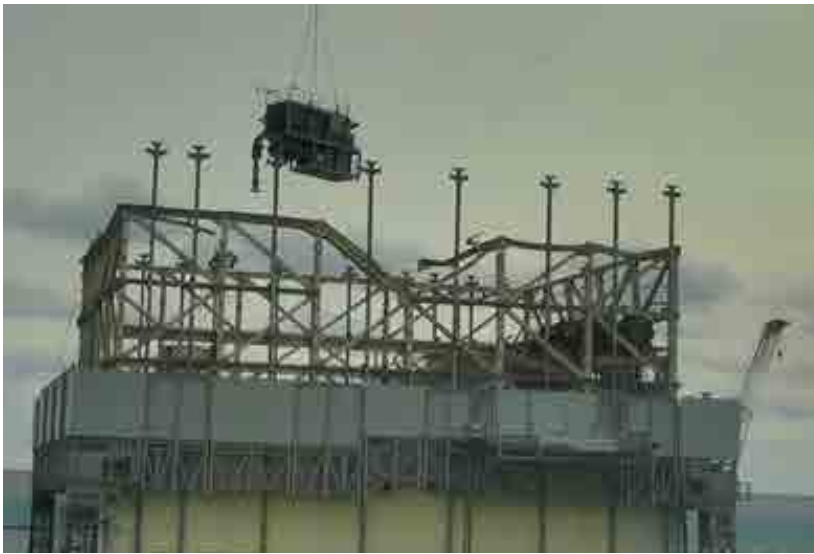
建屋にある小さながれきを吸引する作業（出典：東京電力ホールディングス）
