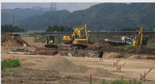
大熊IC 整備工事の様子
