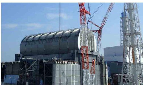
設置が完了した3号機のドーム屋根（出典：東京電力ホールディングス）
