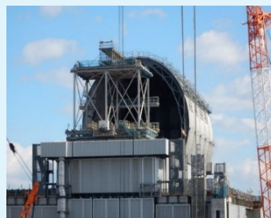
(上の写真) カバーを取り除いた左奥の1号機と新たな設備が加わった右手前の2号機 (下の写真) 円筒形の囲いが設置された3号機
