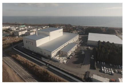
2月から本格稼働する仮設焼却施設
