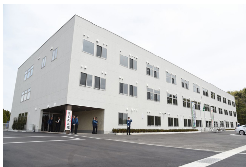
完成した新事務所
