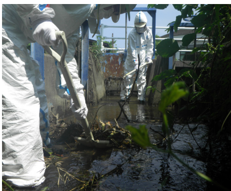
水路の土砂上げ作業の様子
