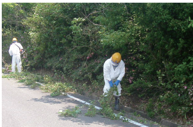
〈昨年度の町内維持工事の様子〉 公道側に伸びた立ち木の伐採
