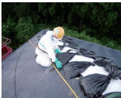
〈昨年度の屋根養生工事の様子〉
