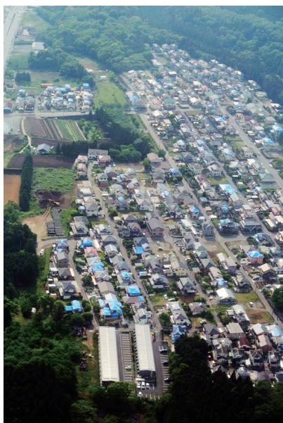
◀上空からの熊本市の様子。屋根にブルーシートがかかる家屋が目立った
