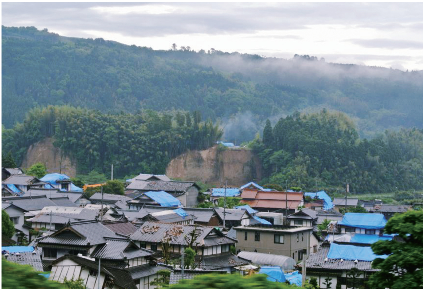
阿蘇郡の多くの自治体では山が削れ、家屋も屋根瓦が落ちたり大きく傾いたりしていた▼
