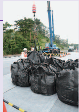
駐車場に搬入される除染廃棄物
