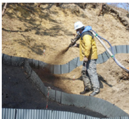
法面客土吹付け
