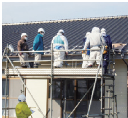
雨樋ふきとり
