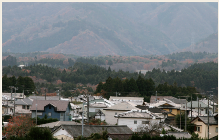
シートの劣化はさげられない
