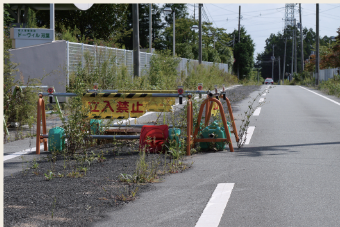
応急処理された町道
