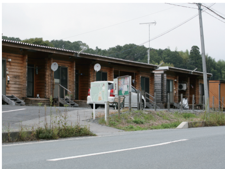
県道脇のいわき市渡辺町仮設住宅
