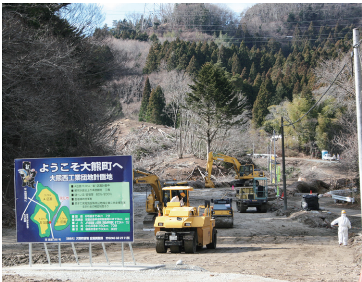
除染が進む西工業団地計画地
