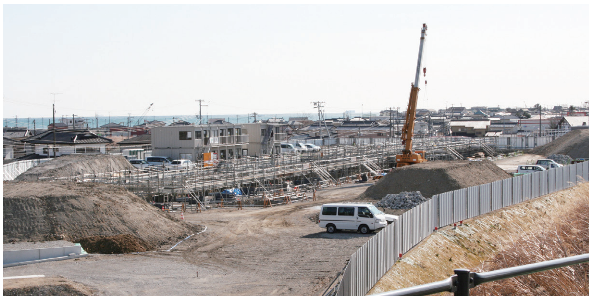
建設中の復興公営住宅
