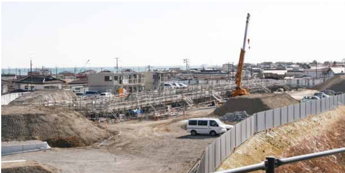
建設中の復興公営住宅
