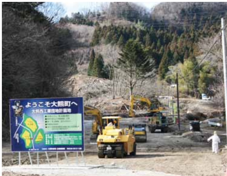
除染が進む西工業団地計画地
