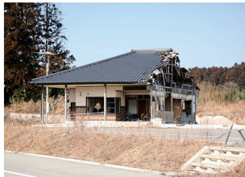
津波被害にあった建物 住宅再建が進むことを期待
