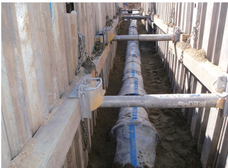
大川原地区下水道 まもなく復旧
