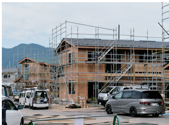
小川駅前に建設中の集合住宅
