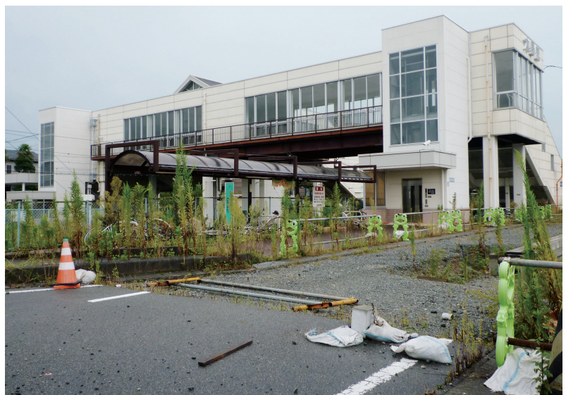
復興の中心となる大野駅（平成32年4月全線開通予定）
