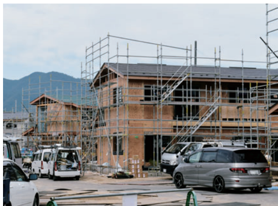
小川駅前に建設中の集合住宅
