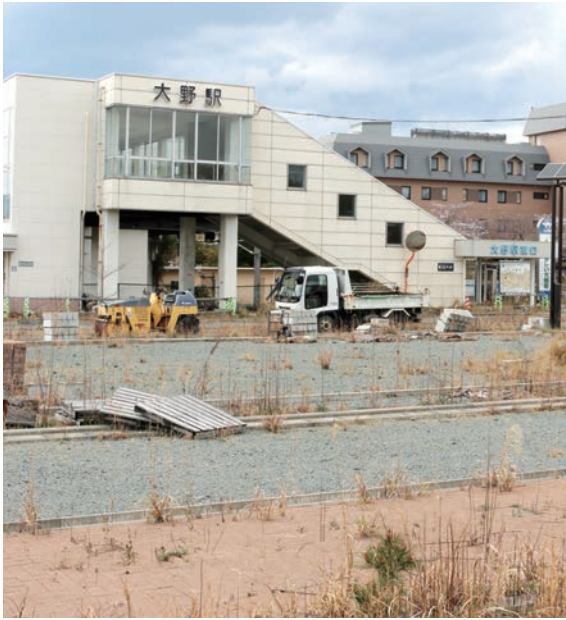
復興へ駅の復旧は欠かせない
