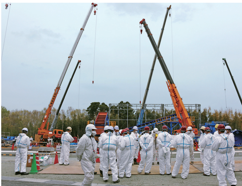
施設整備が進んでいることを確認しました
