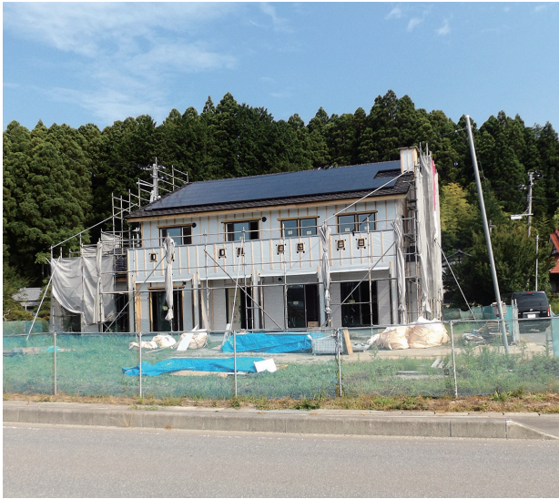
大川原に現在建設中の2世帯住宅
