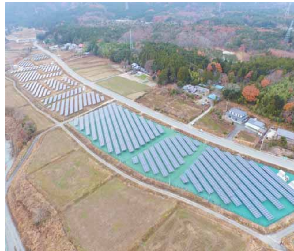
大川原で稼働したメガソーラー
