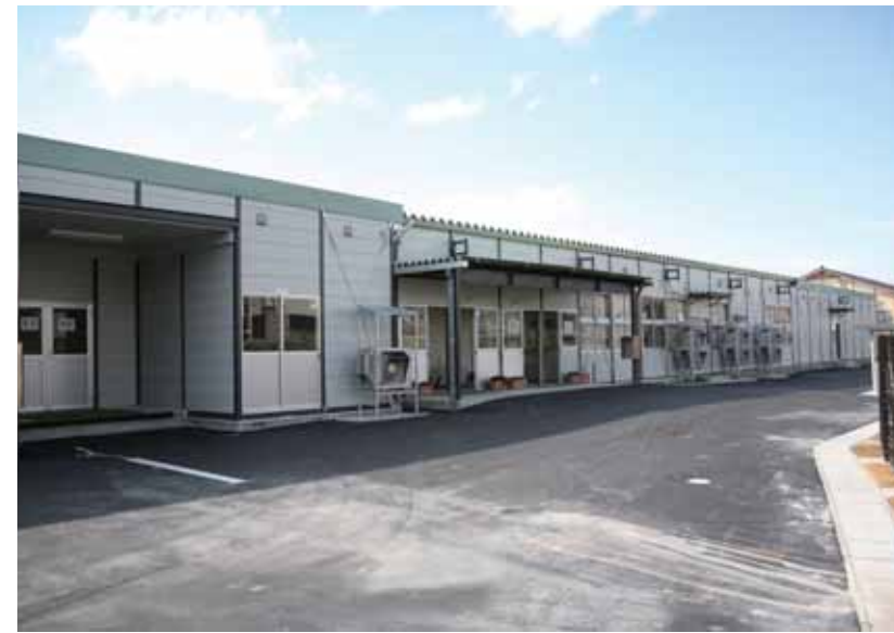
プレハブ造りの大熊中仮設校舎
